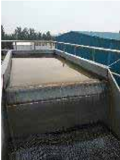
Wastewater Treatment 污水處理
